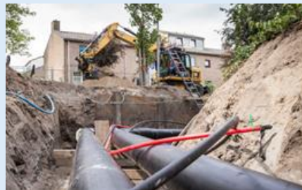
Ondergrondse warmteleidingen
